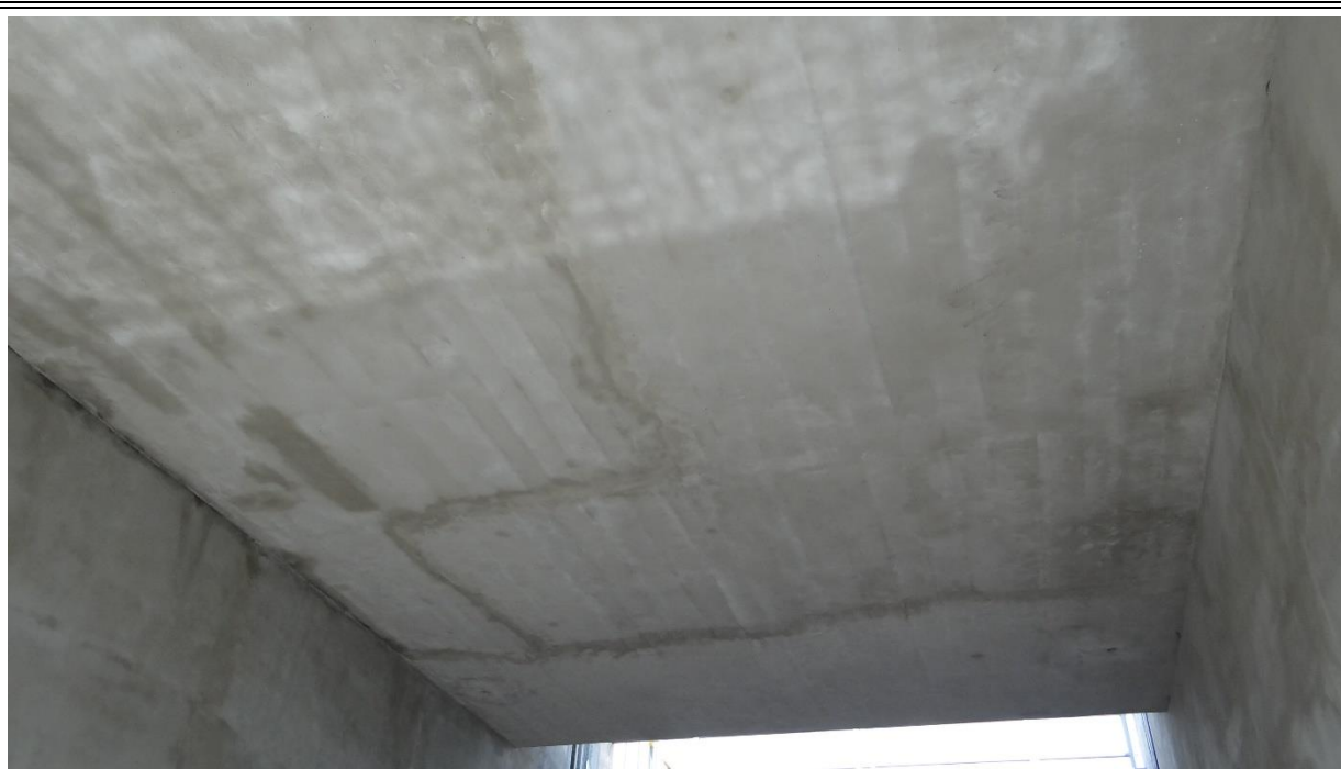
Rysunek 4. Zacieki wody na spodzie konstrukcji przęsła od strony Chojnic.
