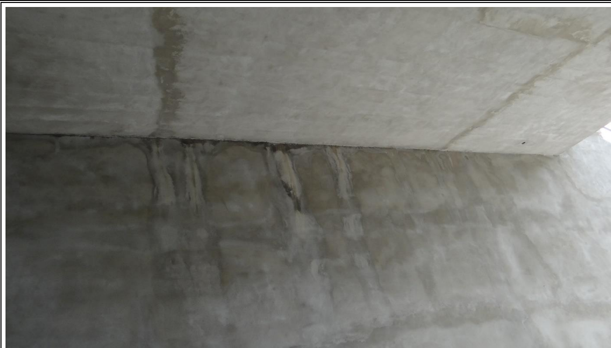
Rysunek 5. Zacieki wody na spodzie konstrukcji przęsła od strony Brus.
